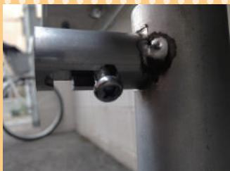
シャフトのポジション穴へのはまり込みは、ばねだけに頼らず、そこへねじ込む事が可能な「L字形状」なっている。
